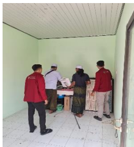
Revitalisasi / renovasi ruang PKK
